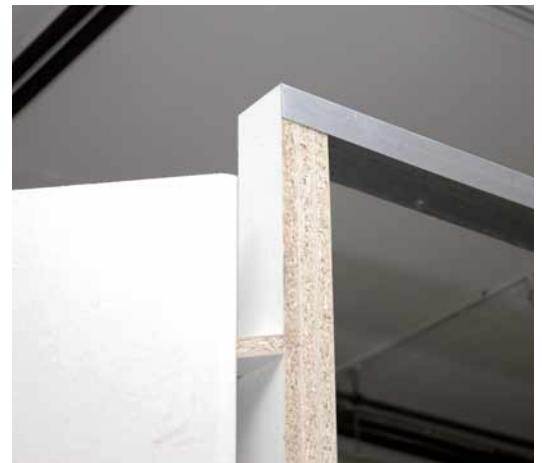
Aufnahmedetail. Zu sehen ist der obere Haltepunkt des U-Profiles an dem Eckelement der Raumzelle. Es fehlt noch die Verschraubung.
