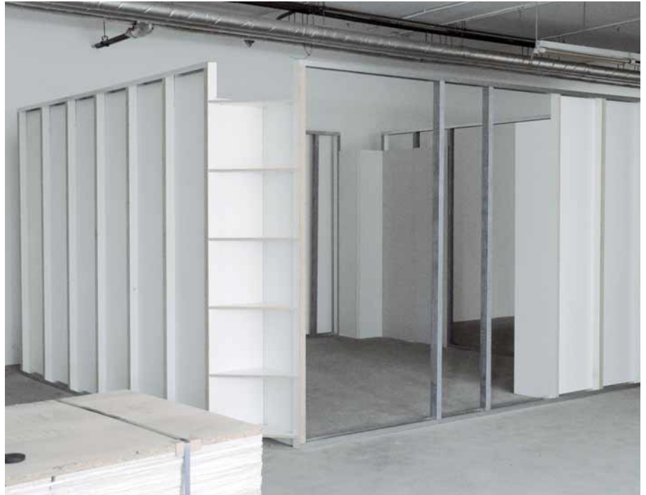
Sowohl als auch. Das System hebt die Trennung zwischen Wand und Schrank auf. Sobald der Schrank zu Ende ist, wird die Trockenbauwand in den gleichen U-Profilen weitergeführt.
