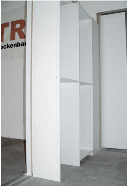
Fertige Ecke. Trel Produktmanager Heinrich Amlang demonstriert, wie einfach der Übergang von Eckelement auf Trockenbauwand ausgebildet ist.
